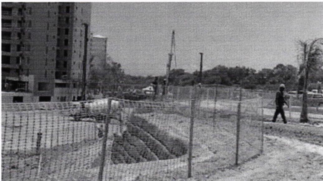
Figura 31: Referência de instalação da tela de segurança.
