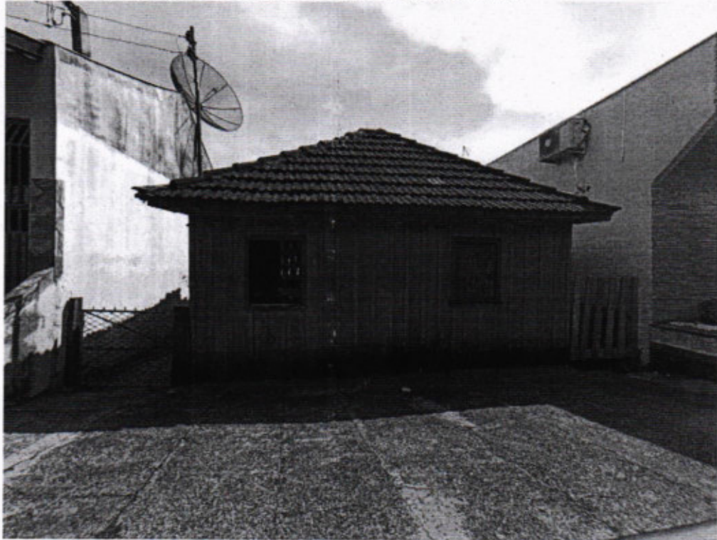
Figura 13: Imagens do terreno
