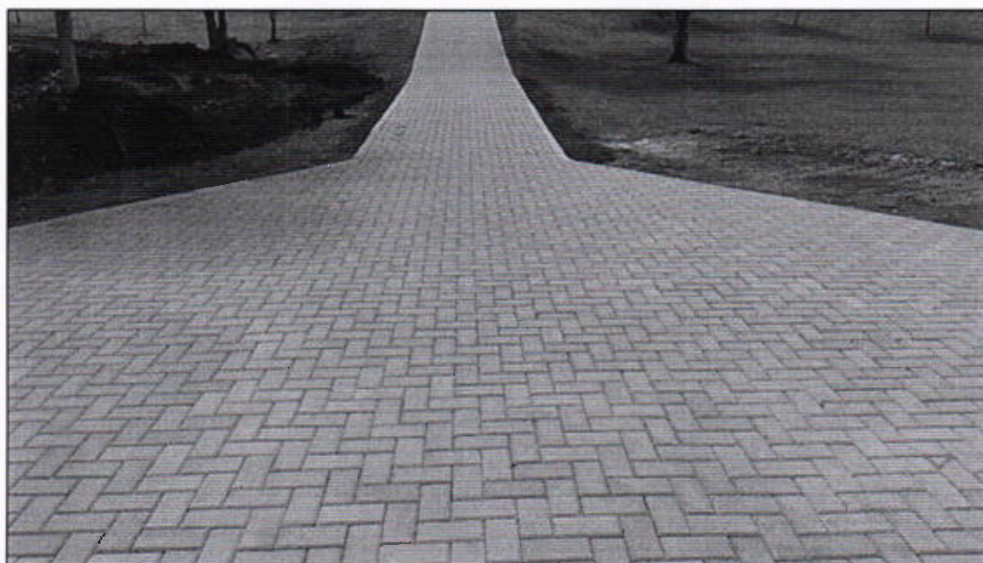
Figuras 11: Forma de instalação do paver
