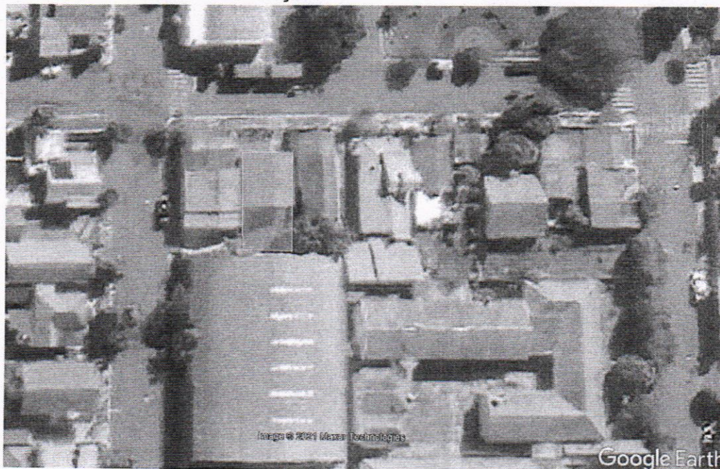
Figura 01: Prédio Secretaria Municipal de Educação
