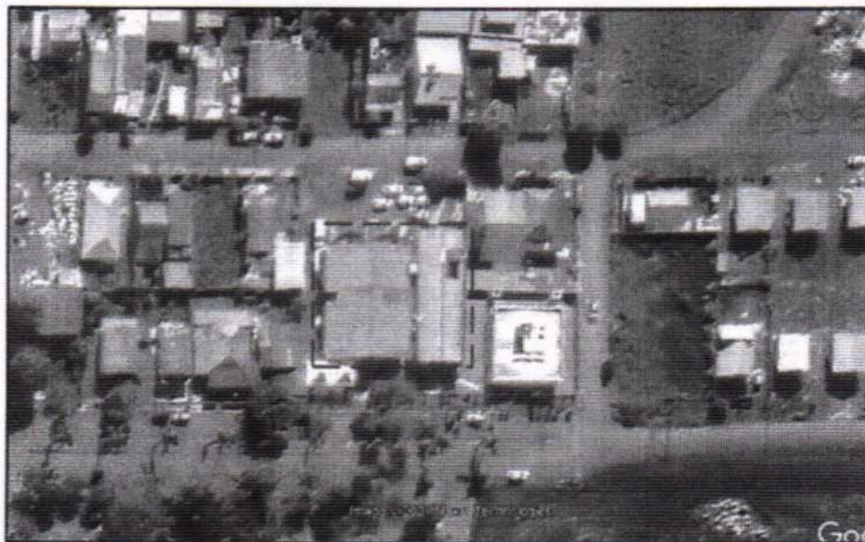
Figura 01: Centro de Saúde Municipal – Posto de Saúde a ser reformado. Fonte: Google Earth Adaptado.
