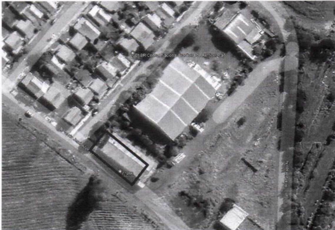
Figura 01: Vista de Satélite.
