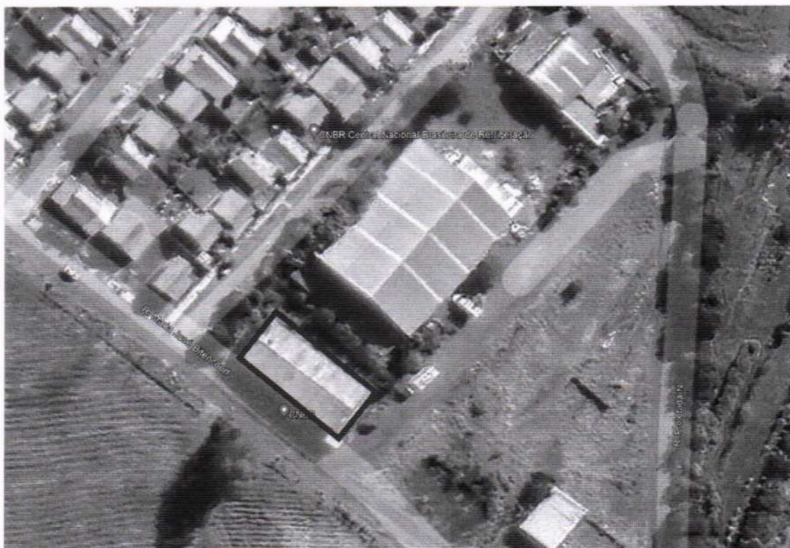
Figura 01: Vista de Satélite.
