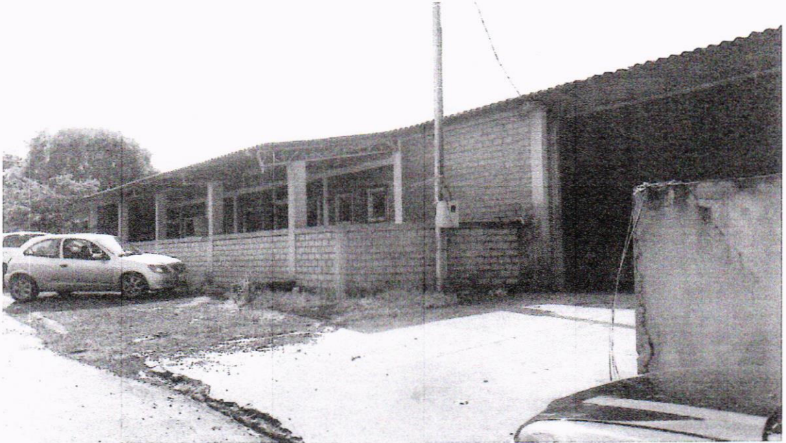
Foto 2: Lateral do imóvel
