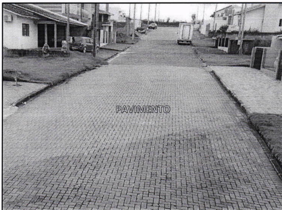
Figuras 03: Forma de instalação do paver
