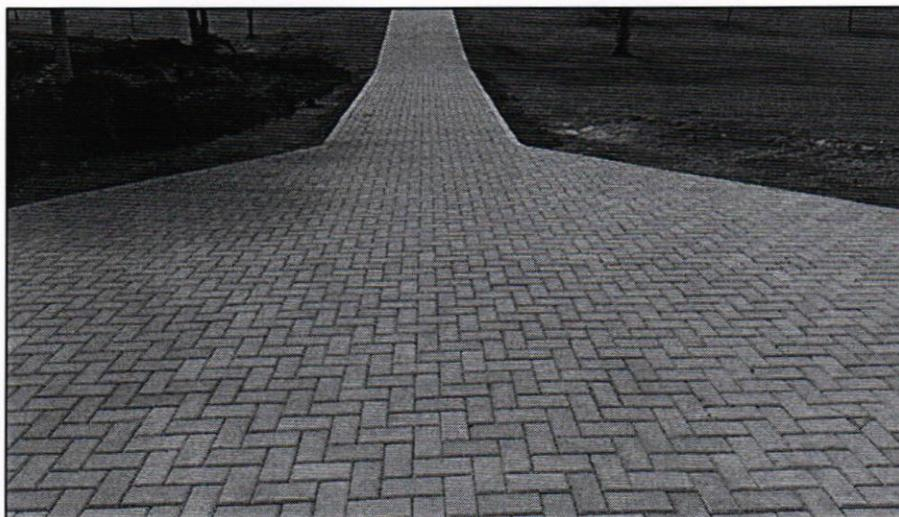
**Figuras 09:** Forma de instalação do paver
