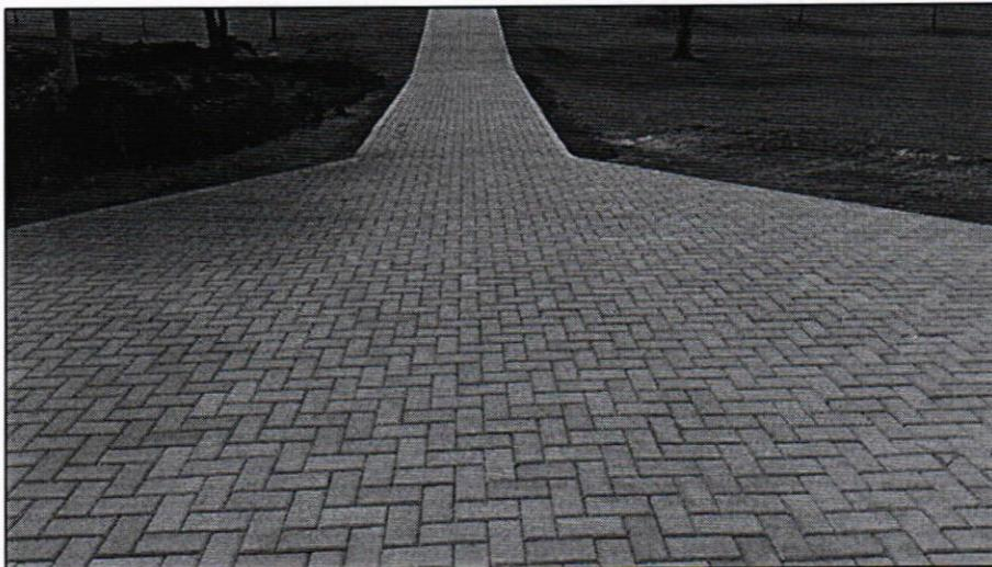
**Figuras 02:** Forma de instalação do paver
