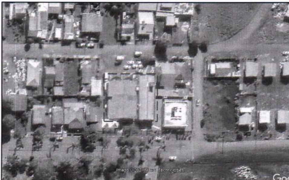
Figura 01: Centro de Saúde Municipal – Posto de Saúde a ser reformado. Fonte: Google Earth Adaptado.
