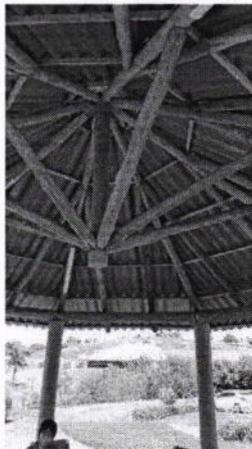
**Figura 21:** Estrutura em madeira da cobertura
