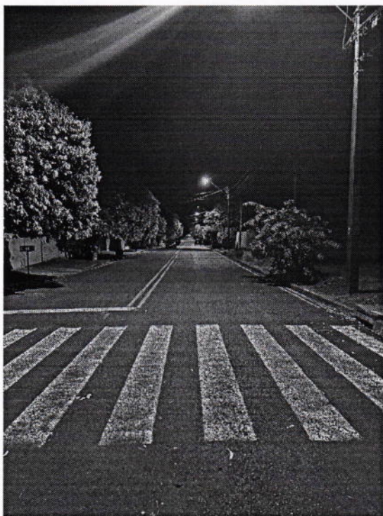
F29 – Luminárias de LED instaladas na Rua Luiz Henrique Sabaine (noite)
