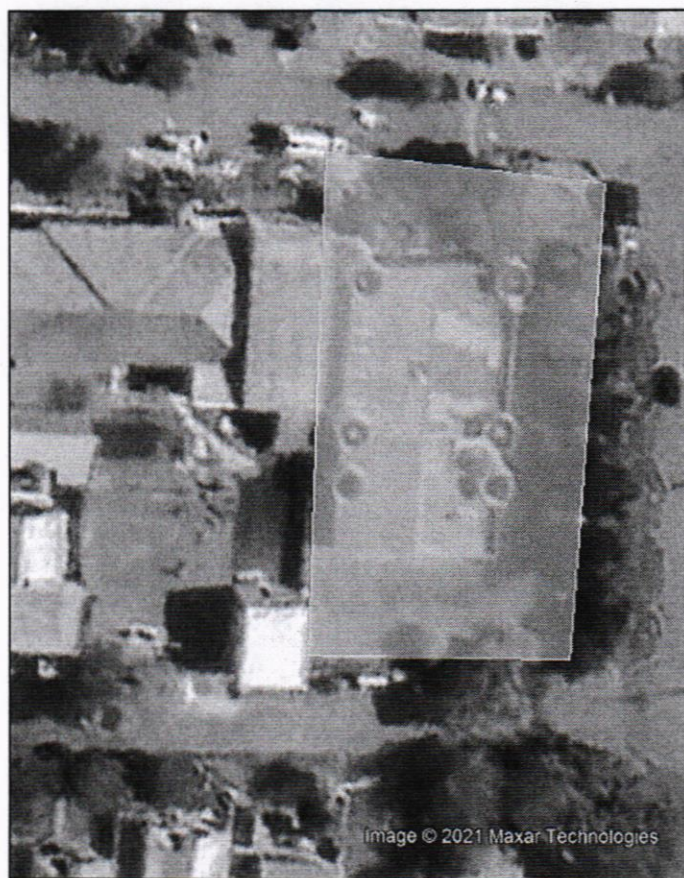
Figura 01: Centro Municipal de Educação – Prédio 01
