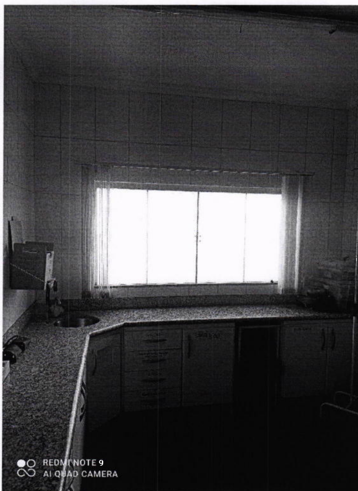
Parede da Sala de Emergência
