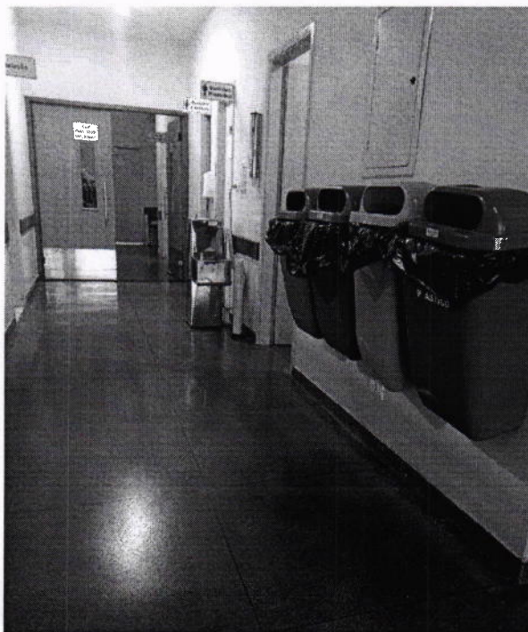
Corredor com rodapé em granilite
