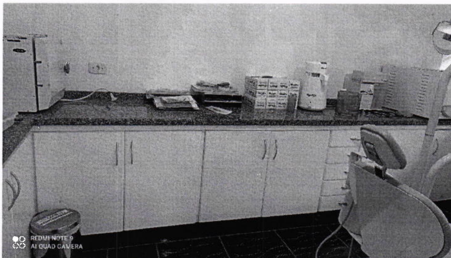
Bancada da Sala odontológica com patologia
